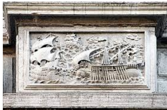
Dettaglio facciata Chiesa S. Maria del Giglio
