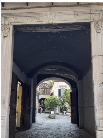
Ingresso da Vico Cappella Vecchia
