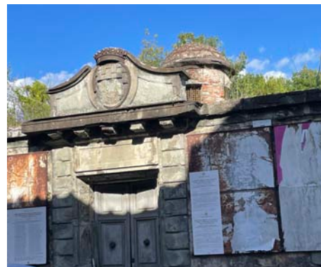
Capostrada (Pistoia), Bacino di carico.
