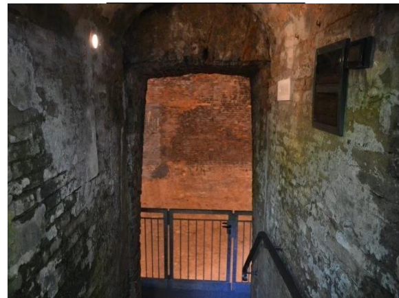
accesso e interno della ghiacciaia
